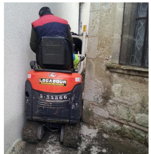
La micro-pelle à l'œuvre derrière l'église
